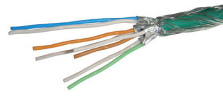
Paare aufdrehen und Adern strecken, wie links anordnen, gestuft zurückschneiden und gemäss Farbencode in die Montagehilfe einführen.
