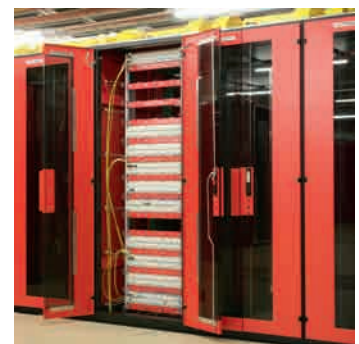
Rechenzentrum Bundesamt für Informatik, Bern
